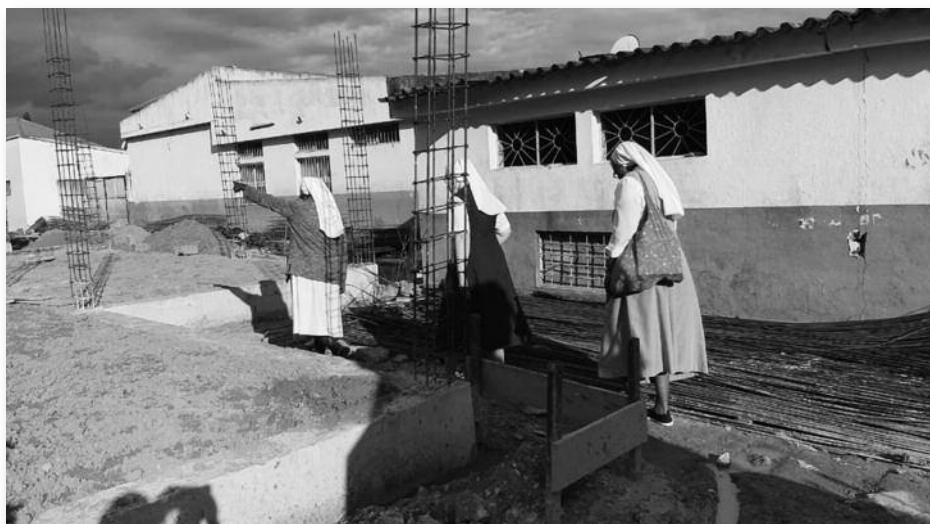
Photos du chantier supervisé par les soeurs.
